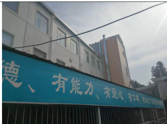
核医学排风管道
