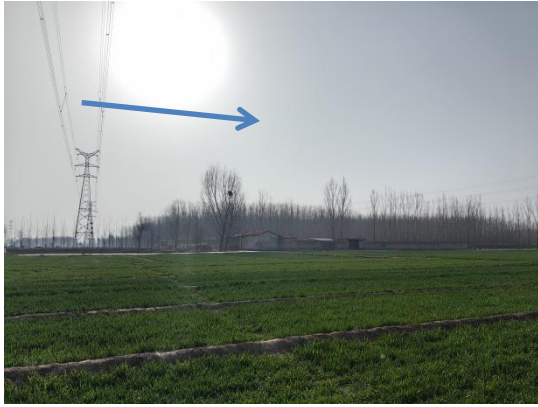
尚舜线/孙顺线双回线路47#~48#杆塔南侧衰减
