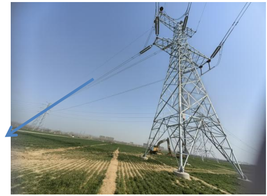
尚顺单回线路25#~26#杆塔东北侧衰减
