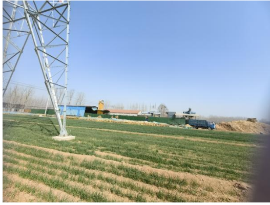
13、220kV 顺林线/220kV 桥顺线 27~28 号杆塔之间，边导线北侧约 37m，西桥村南侧玉米秸秆加工厂
