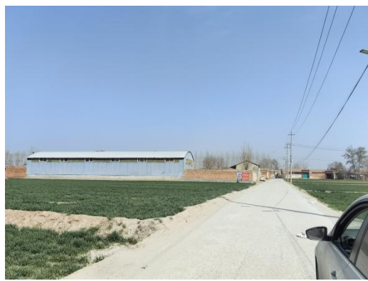
15、220kV 顺林线/220kV 桥顺线 45~46 号杆塔之间，边导线北侧约 35m，房村南侧看护房
