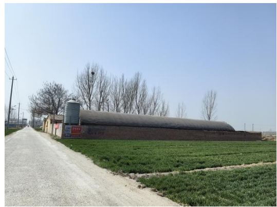
16、220kV 顺林线/220kV 桥顺线 45~46 号杆塔之间，边导线南侧约 39m，房村南侧养殖棚看护房
