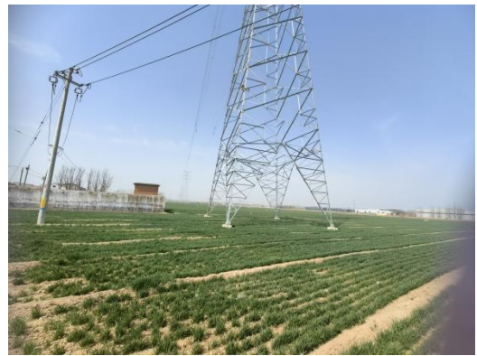
18、220kV 顺林线/220kV 桥顺线 62~63 号杆塔之间，边导线南侧约 5m，于林头村东侧看护房
