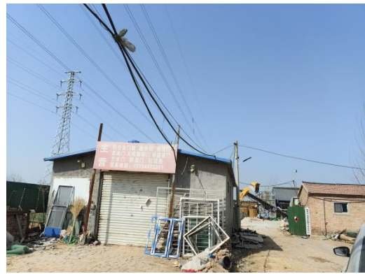
12、220kV 顺林线/220kV 桥顺线 27~28 号杆塔之间，边导线北侧约 10m，西桥村南侧工厂
