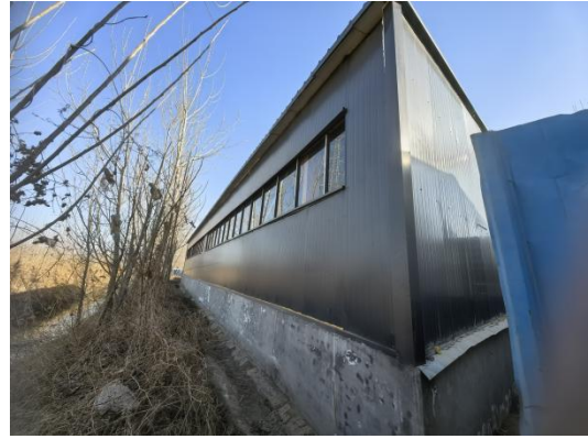
2、220kV 尚顺线/220kV 孙顺线 61~62 号杆塔之间，跨越，前堤村北侧加工厂房
