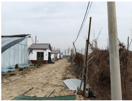
9、220kV 孙顺线 50~51 号杆塔之间，边导线西北约 23m，芦行村西南大棚看护房 3 处
