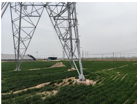
桥顺线/柴林III线 103#塔基下方生态恢复
