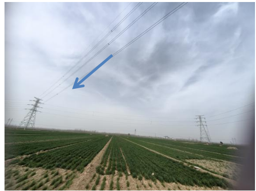
柴林III线单回线路77#~78#杆塔东北侧衰减
