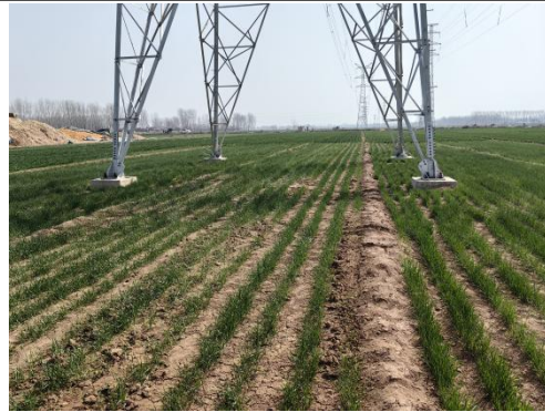
顺林线/柴林III线 28#塔基下方生态恢复
