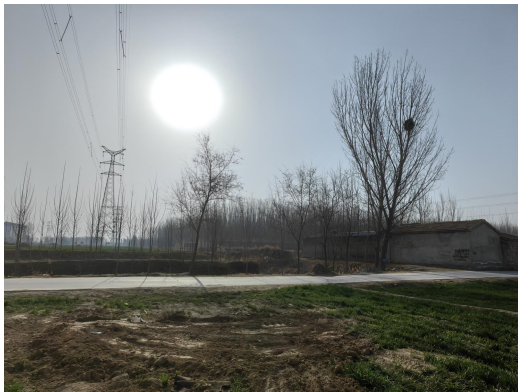
5、220kV 尚顺线/220kV 孙顺线 54~55 号杆塔之间，边导线南侧约 31m，前汪堤村南侧的民房 3 处
