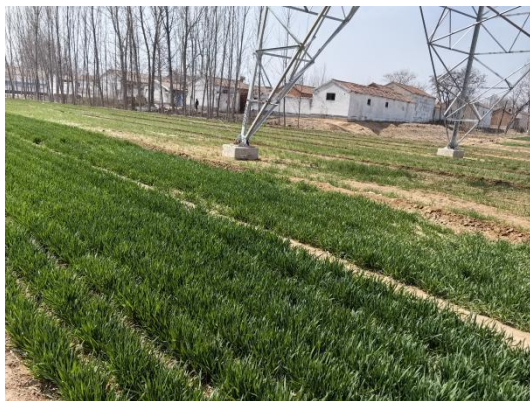
17、220kV 顺林线/220kV 桥顺线 61~62 号杆塔之间，边导线南侧约 36m，于林头村北侧民房 6 户
