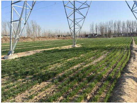
尚顺线/孙顺线 59#塔基下方生态恢复
