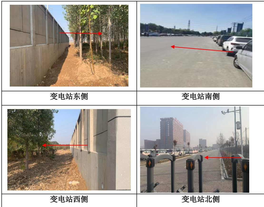
图 4-3 东环 110kV 变电站四周现场照片
