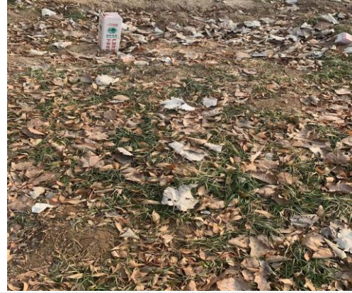
临时堆土场恢复
