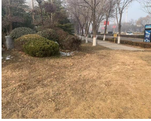
电缆施工恢复
