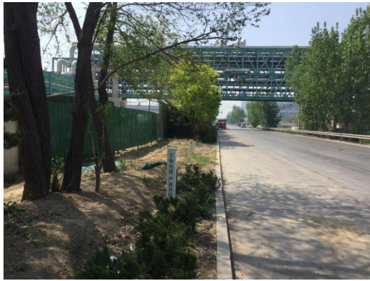
图 4-14 电缆线路沿瑞丰大道向南敷设
