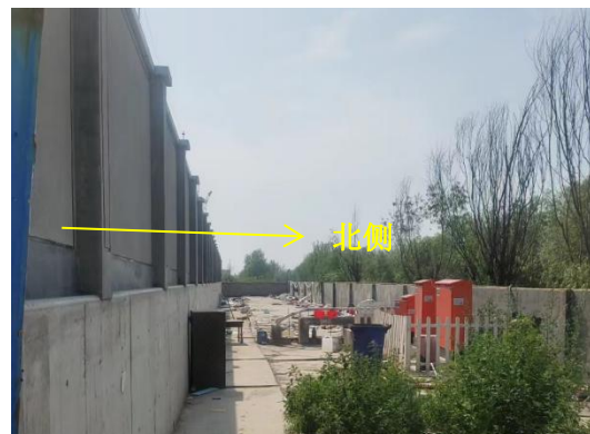
图 4-6 变电站北侧空地
