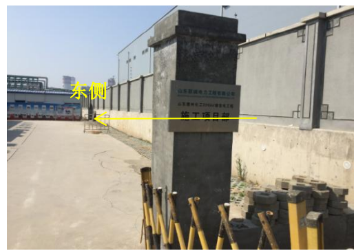
图 4-4 变电站东侧中联大道
