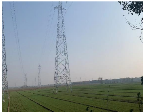
跨越马颊河处塔基恢复
