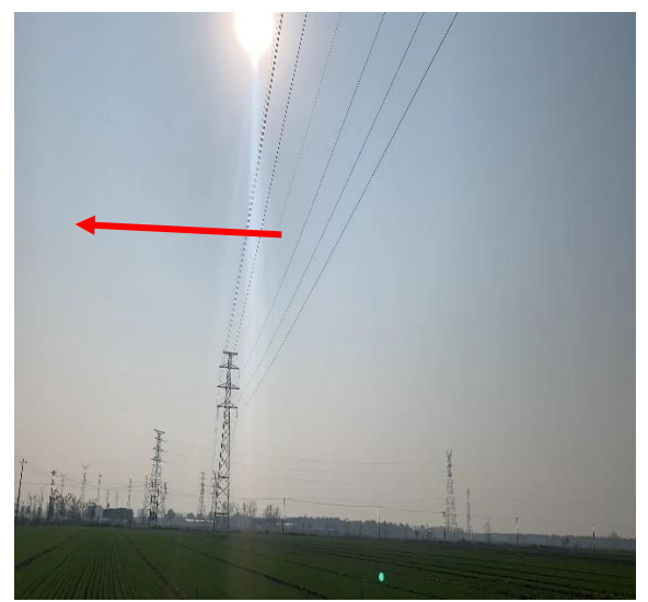
110kV畔寨线12号~13号/110kV岳畔线92号~91号双回架空线路西侧衰减
