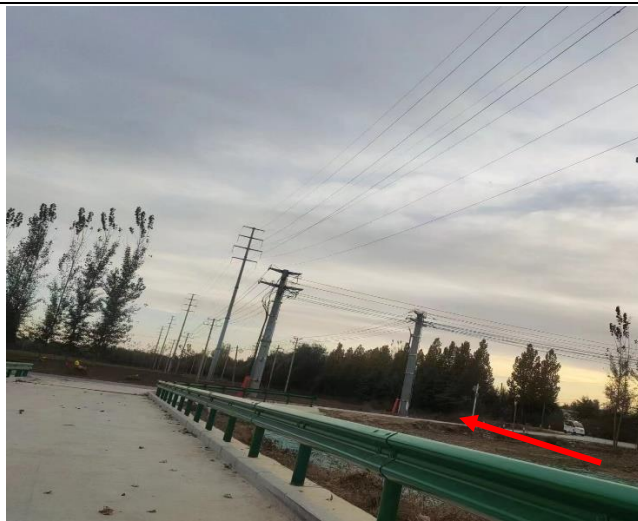
220kV畔城站~110kV畔范线01号/110kV畔郑线01号塔双回电缆南侧衰减
