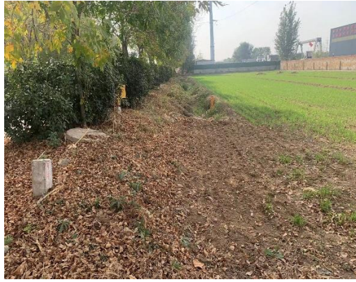
电缆敷设恢复情况
