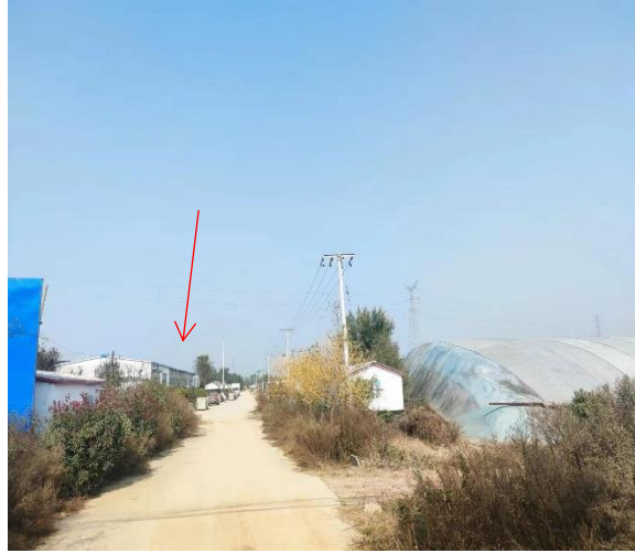
5. 110kV 畔莘线/畔西线 26-27 号杆塔边导线北侧 10m, 山东润涛生态农业发展
