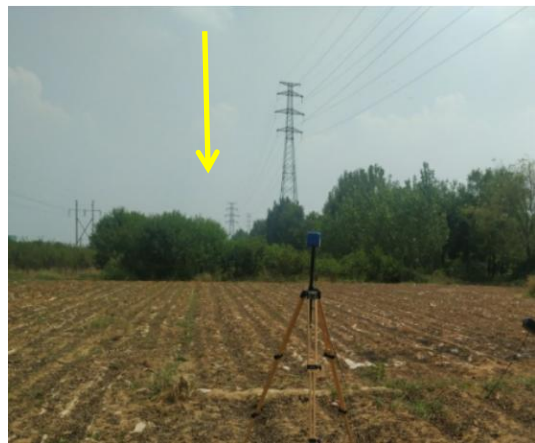
B12: 110kV 丰观线 40#塔~41#杆塔导线衰减
