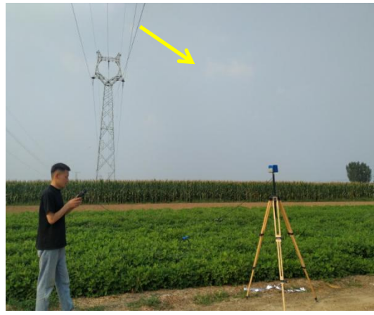
B2:110kV 蒋苗线 14#塔~15#杆塔导线衰减
