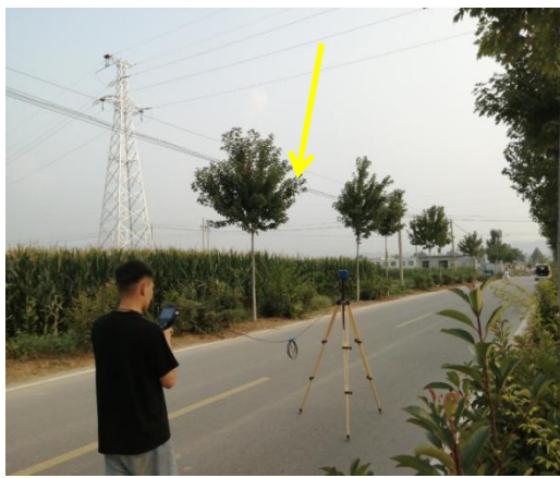
B3:110kV 丰苗线 75#塔~76#杆塔导线衰减
