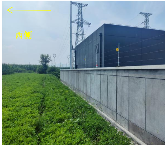
图 4-5 变电站西侧-农田
