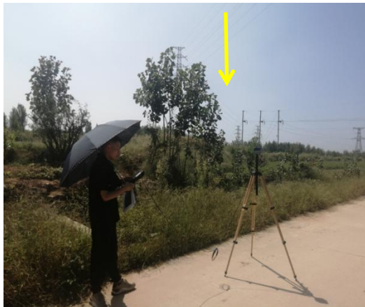
B5:110kV 蒋苗线、蒋观线 10#塔~11#杆塔导线衰减
